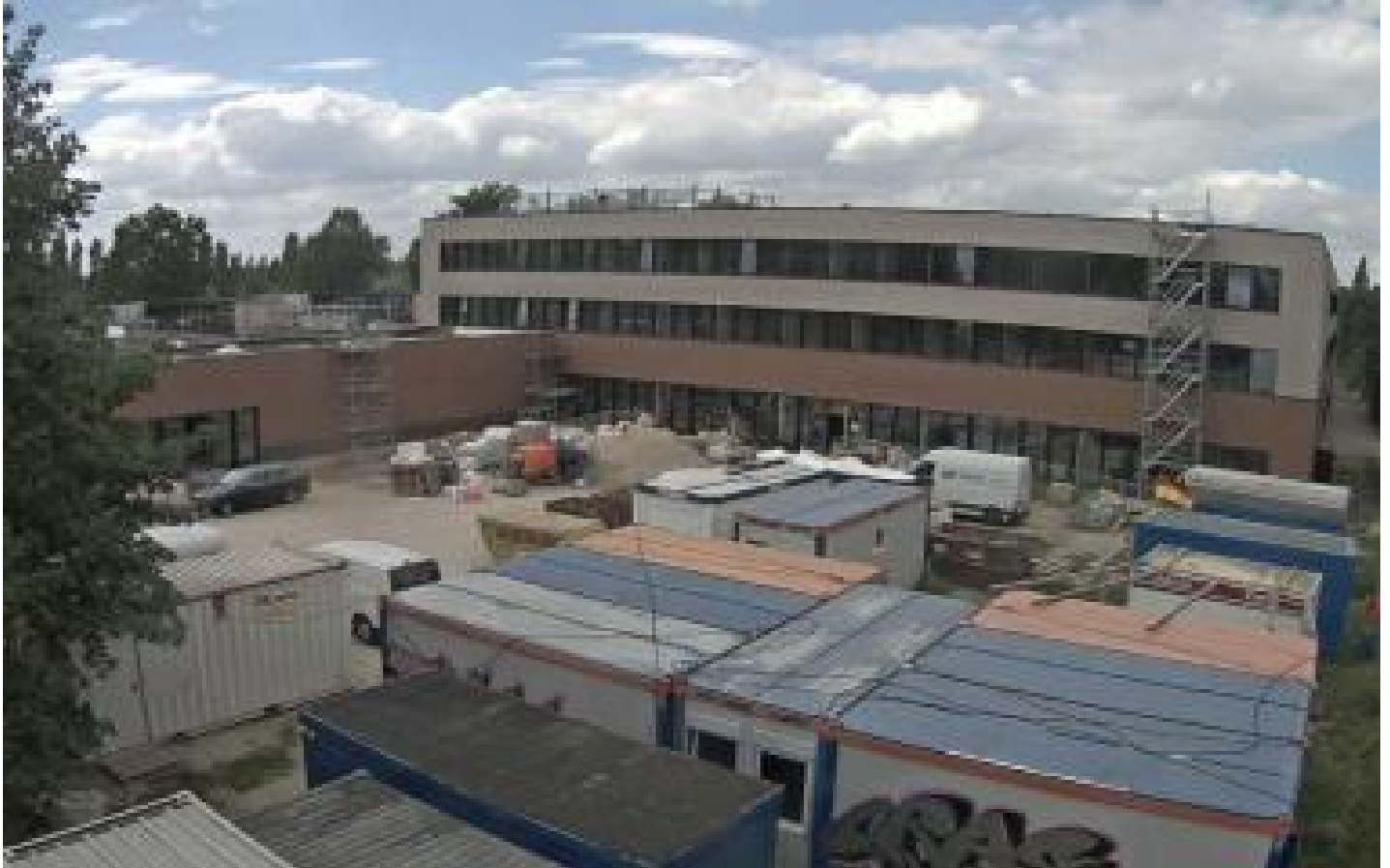
Baustelle Leonardo-Da-Vinci Gesamtschule. Foto KIS Live-Cam
